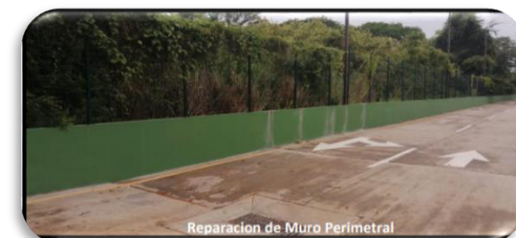
Reparacion de Muro Perimetral
